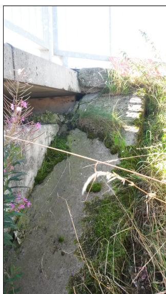
Zpevnění svahu OP2 zprava, ve spárách uchycené mechy.
