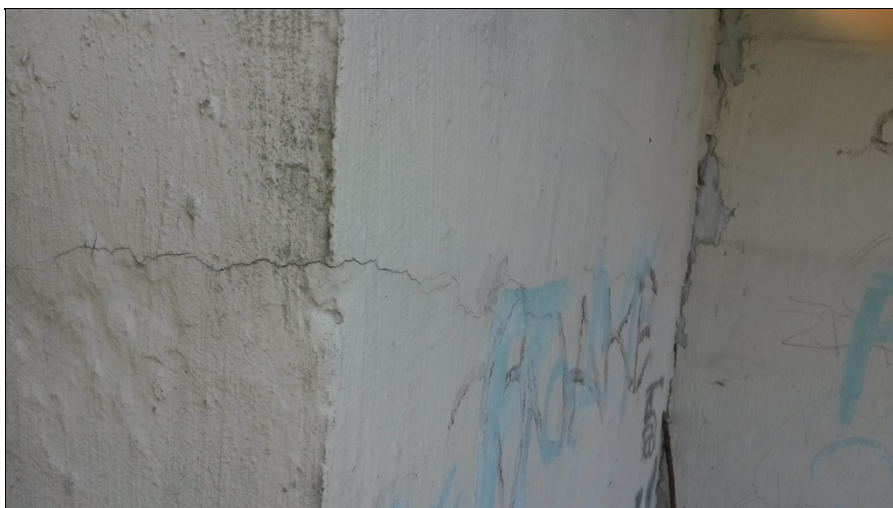
Příčná trhlina v OP1 zprava
