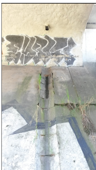
Skluz na OP2 zprava, vydrolená spárová malta, uchycená vegetace
