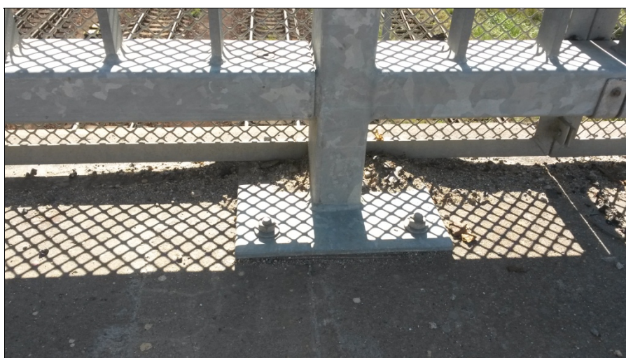
Hromadění nečistot u zábradlí - nízká poloha protidotykové zábrany.
