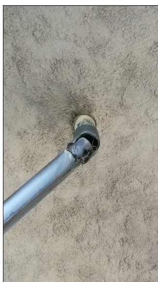
Detail svodu odvodňovače na P1 - prasklý v koleni
