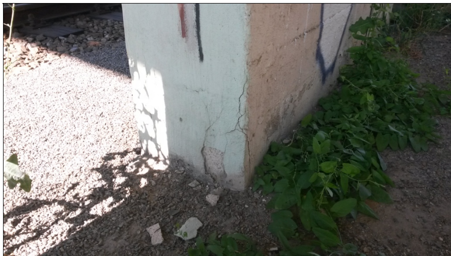
Svislé trhliny na OP2 zleva
