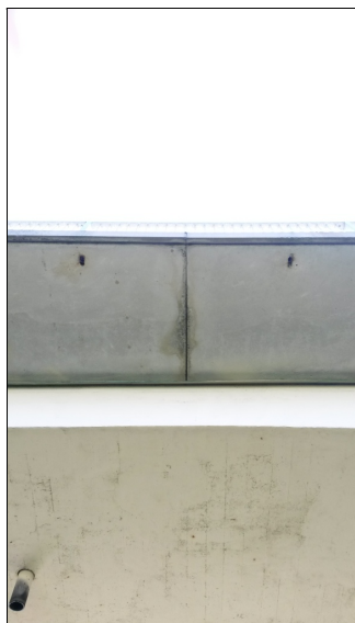
Podhled chodníku - stopy po průsaku ve spáře mezi panely.
