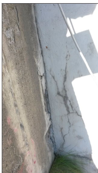
Svislé trhliny na OP2 zleva
