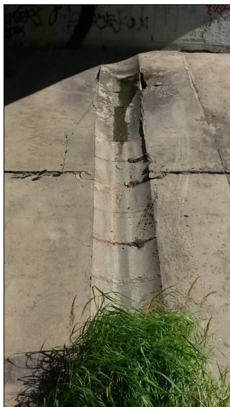
Zarostlý skluz na OP1 zprava, vydrolená spárová malta
