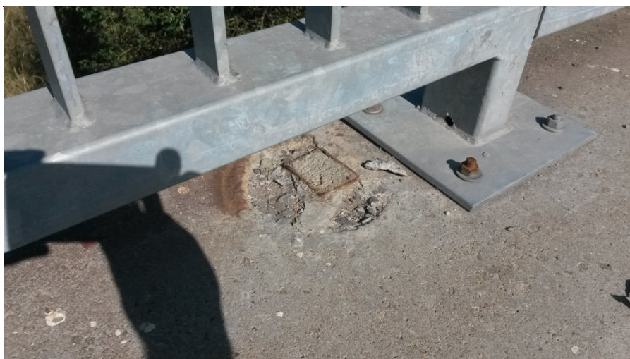
Uřezané původní sloupky zábradlí
