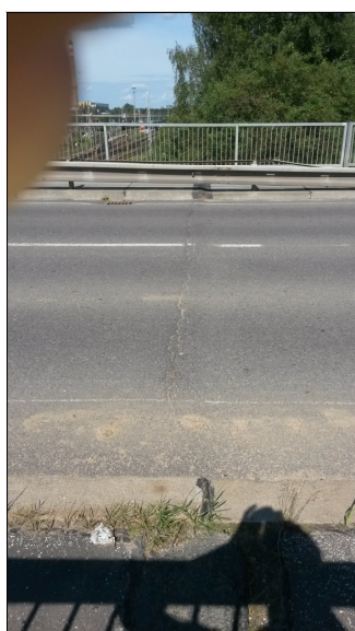
Příčná trhlina ve vozovce nad OP1
