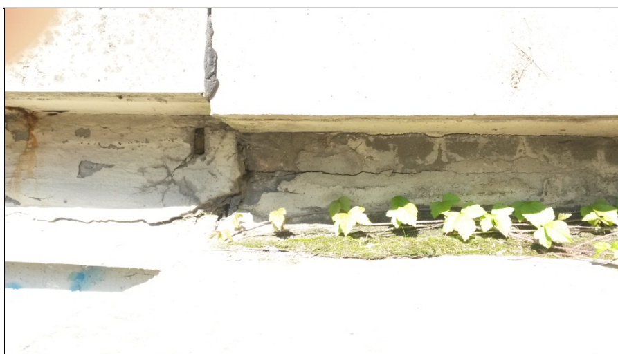
Podhled chodníku - stopy po průsaku ve spáře mezi panely.
