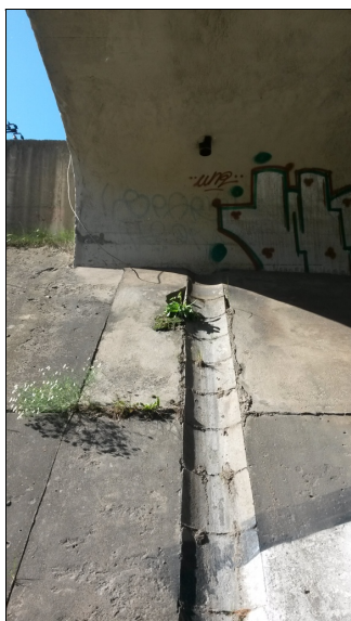
Skluz na OP2 zleva, vydrolená spárová malta, uchycená vegetace
