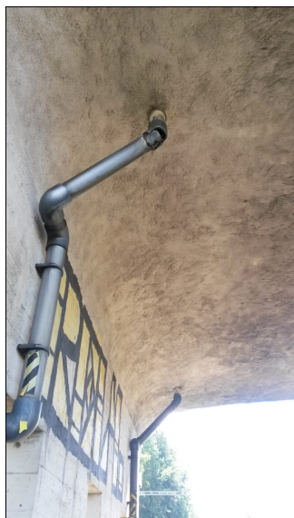
Svody odvodňovačů uchycené na P1 pod mostem - poškození v koleni
